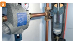
Separador de aire y purga permanente. El aire sube en el HF3415, el flotador baja y abre la válvula para soltar el aire.
